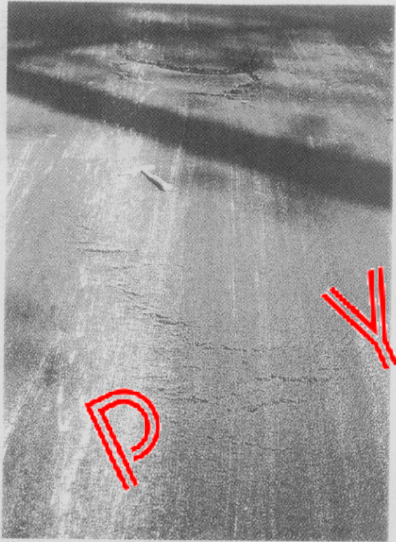
滑动：铺面两层之间缺少粘结的情况，这通常发生在道路开始使用时最初的数个月。
