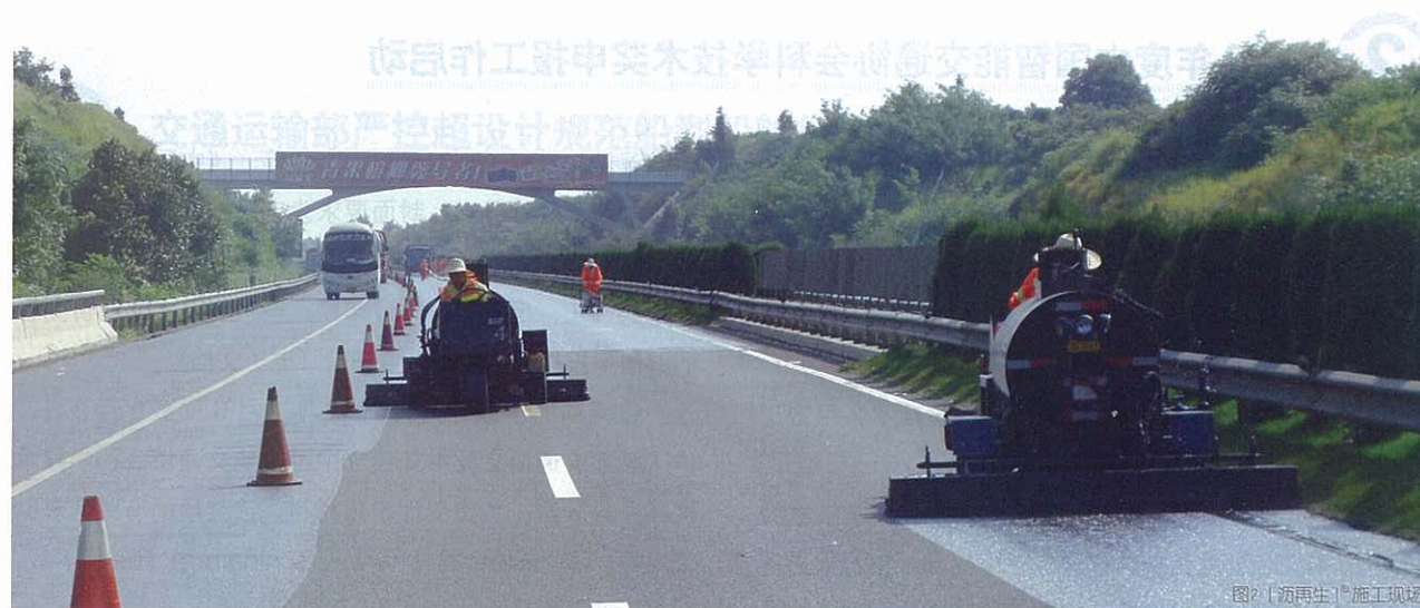
图2 [ 沥再生 ] ® 施工现场
