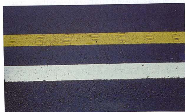
图1 施工后的常张高速公路
